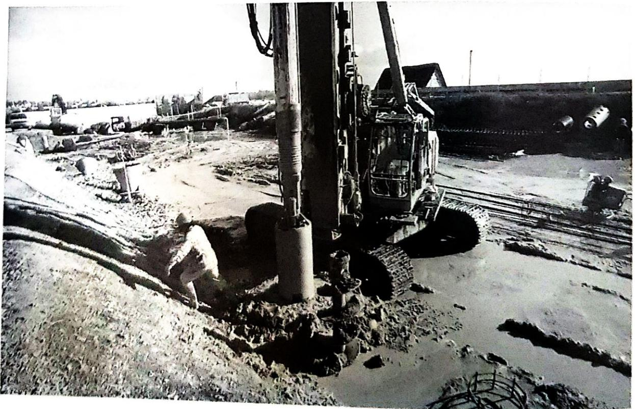
L'un des 94 pieux en béton armé est mis en place (photo Rémy Wenger).
